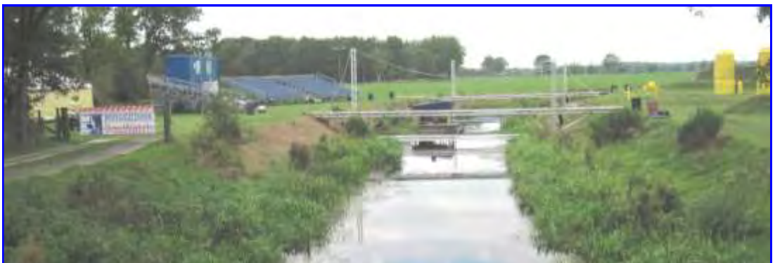
De voorbereidingen van Operatie Grensland aan de Hearsterwei-Skieding zijn al weken van tevoren gestart
